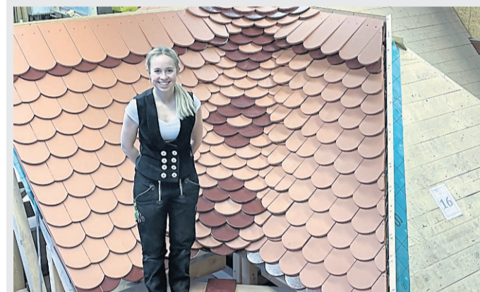
Carolin Staubach mit ihrem Meisterstück, einer eingebundenen Bieberschwanzkehle. Fotos: Staubach
