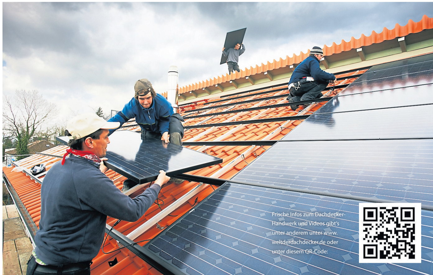
Eine Photovoltaik-Anlage wird vom Dachdecker auf dem Dach montiert und vom Elektriker angeschlossen. Foto: Adobe Stock
