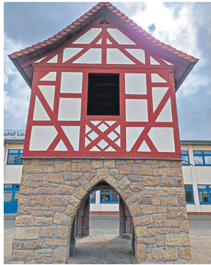
Beim Bau des Hauses vor dem Lauterbacher Lehrbauhof wurde Naturstein aus dem Steinbruch in Angersbach verwendet. Alle Steine wurden per Hand bearbeitet. Fotos: Graupner
